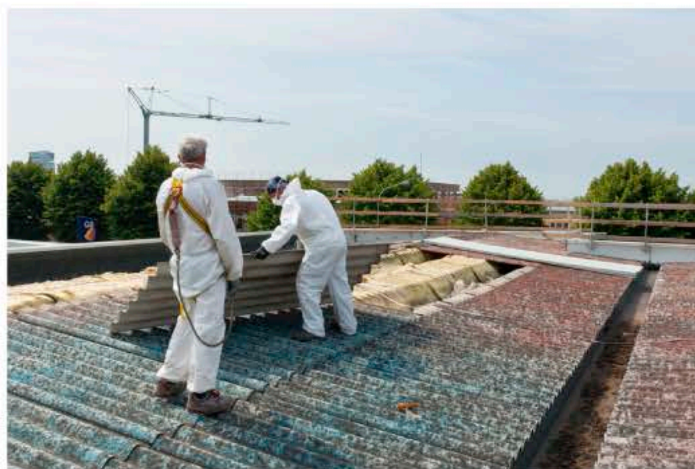
รูปที่ 1.10 หลังคาซีเมนต์แอสเบสตอส
