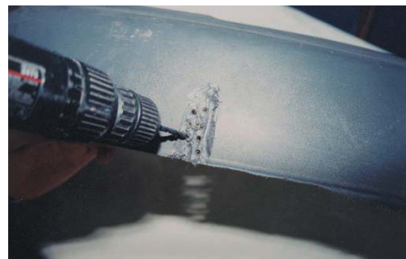
รูปที่ 2.12 การใช้สว่านเจาะรู
