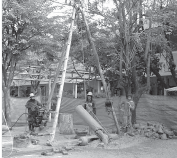
รูปที่ 2.9 การเจาะเสาเข็มขนาดเล็กแบบแห้ง
