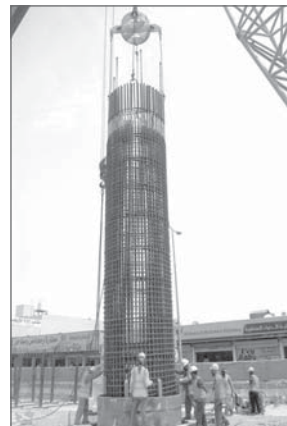
รูปที่ 2.10 การใส่เหล็กเสริมในเสาเข็มเจาะขนาดใหญ่
