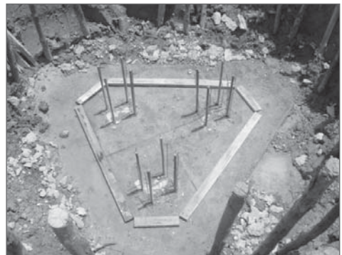
(ข) การตัดที่เหล็กลึกเดียวเสริมพิเศษ (Extra Dowel)
