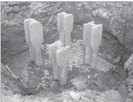
(ก) วิธีเตรียมการตัดหัวเสาเข็ม
