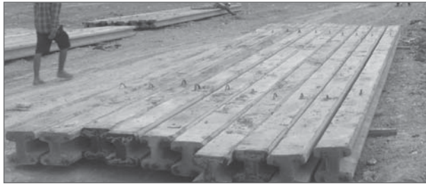
รูปที่ 2.12 การหนุนไม้หมอนตามตำแหน่งที่เกิดค่าโมเมนต์ เพื่อลดการแอ่นตัวและแตกร้าว
